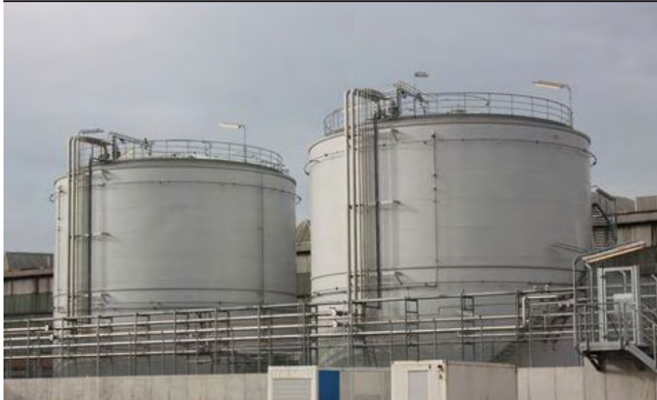
Außenansicht der Tanks nach 5 Jahren! Die Beschichtung ist immer noch intakt. Keine Witterungserscheinungen oder Korrosionsschäden sind auf der Oberfläche sichtbar.
