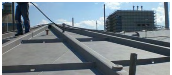
Die Oberfläche nach der fachmännischen Vorbereitung durch Sandstrahlen gemäß ISO 8501-1.
