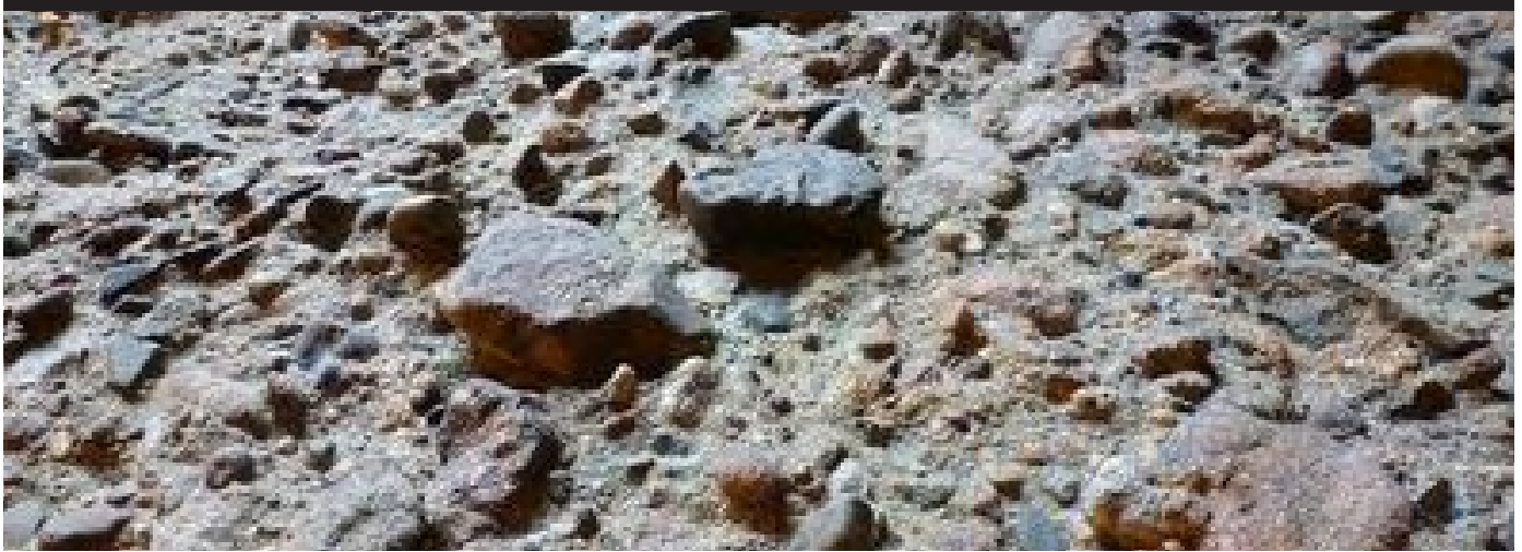
Extreme Betonauswaschungen...
