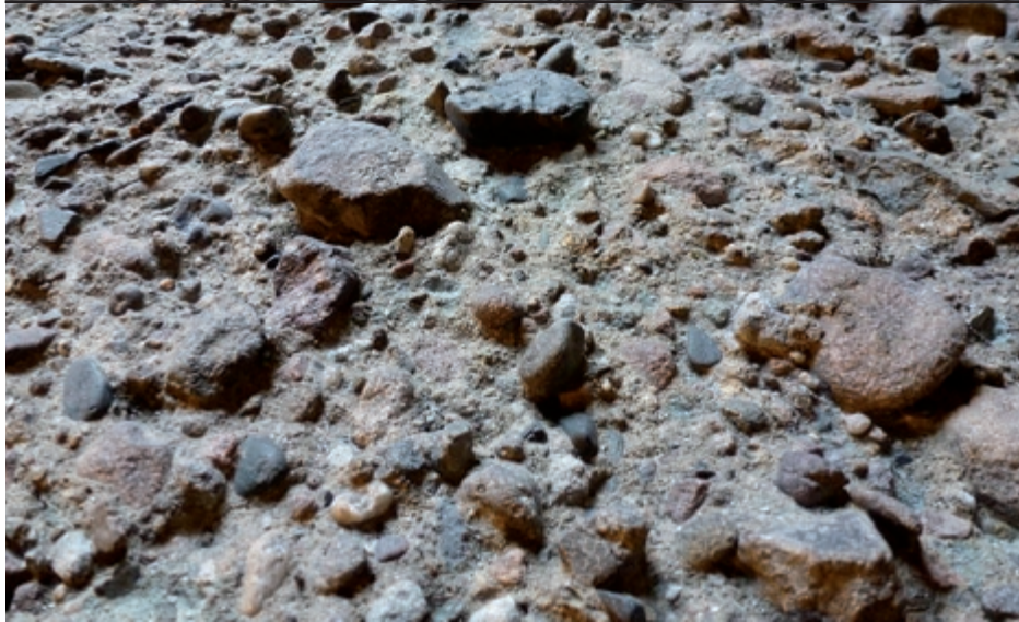
...massive Betonauswaschungen
