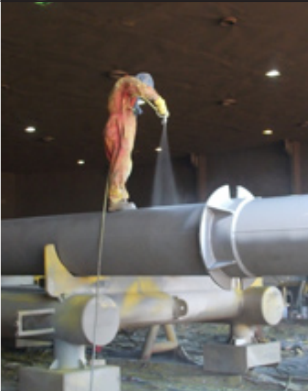
Aplicación de la primera capa – en color gris-
