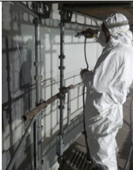
Se aplica en sistema PROGUARD CN 200 mediante proyección con air-less.
