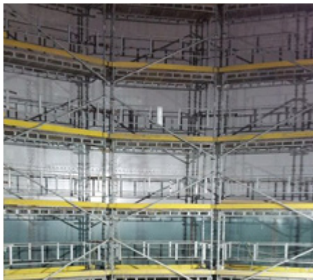
Primera sección completada – Se recubre el área superior.
