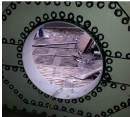
Zusätzliches, flexibles Verfugen der Nieten, Nähte und Stoßkanten.
