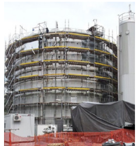
Zusätzliches, flexibles Verfugen der Nieten, Nähte und Stoßkanten.
