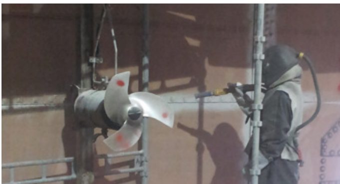
Die Fläche wurde zunächst sandgestrahlt.
