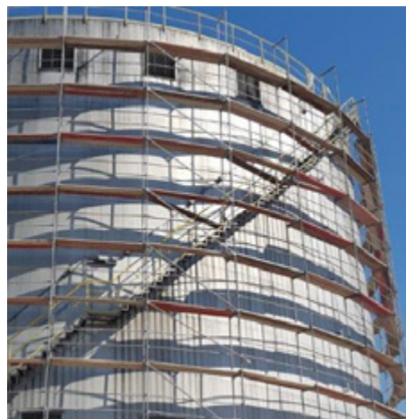
Jeweils eine dünne Schicht der Grundierung und des Top-Coats wurden im Airless-Spritzverfahren aufgebracht.
