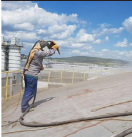
Die Dachfläche wurde durch Sandstrahlen gemäß dem Reinheitsgrad Sa2,5 vorbereitet.
