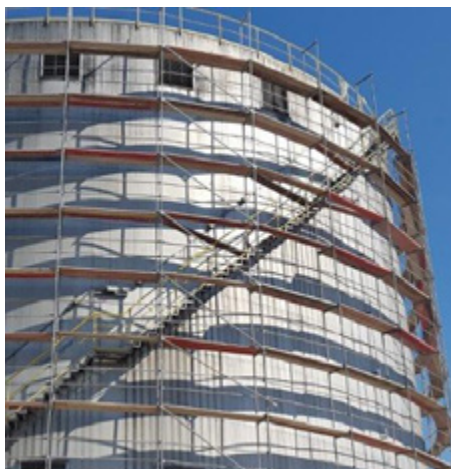
Ambas capas se aplicaron simplemente mediante air-less.
