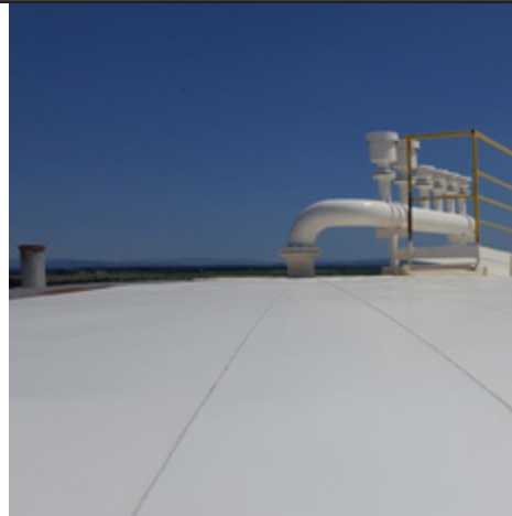
Techo con la aplicación de la primera capa y la capa de acabado.
