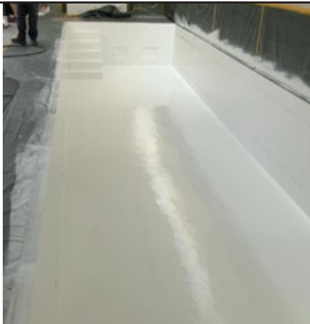
Primera capa de nuestro producto PROGUARD CN 200 en gris claro Se aplicó con el método de proyección air-less.
